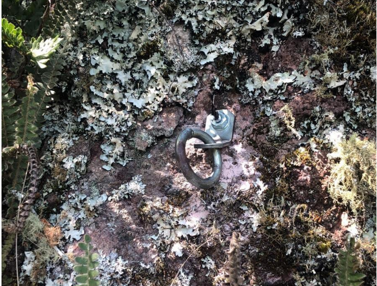
Foto del anclaje tomada al otro día
